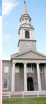
Central Union Church Sanctuary セントラルユニオン教会 (大聖堂)
